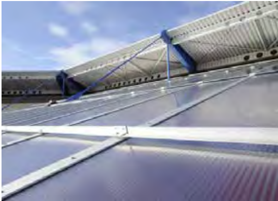
Der Tintendrucker markiert die UV-geschützte Seite der Platte.
